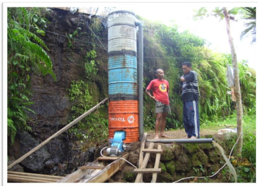
Gambar 81. Penulis Berada di Sekitar Sistem PLTMH Model Drum yang Sedang beroperasi Ditandai Oleh Air Keluar Dari Saluran Limpah (Bachtiar, 2010)
